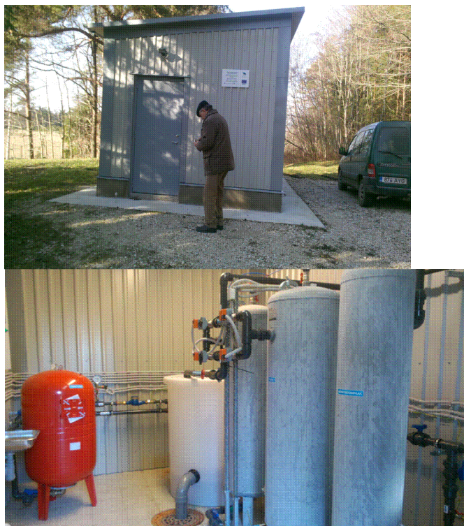
Joonis 5.6 Sutlema puurkaevpumpla ja veetötlusseadmed
