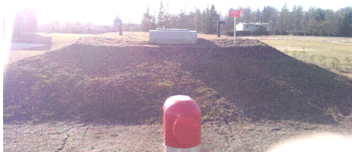
Joonis 5.10 Sutlema tuletõrjeveemahuti
