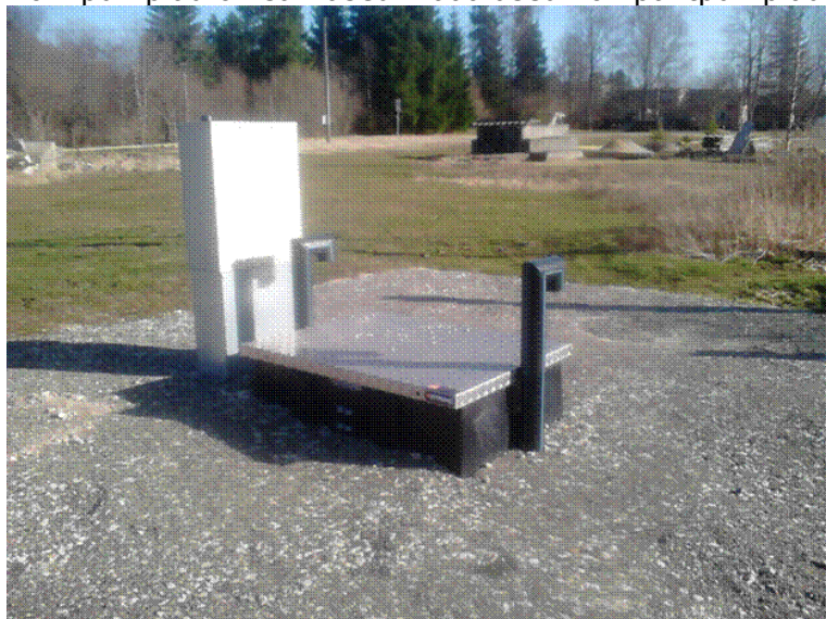
Joonis 6.1 Prillimäe tüüpkanalisatsioonipumpla RP205
