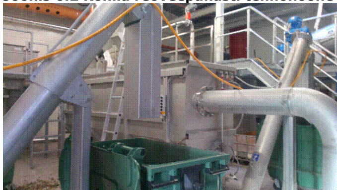
Joonis 6.3 Kohila reoveepuhasti liivapüünis ja võre
