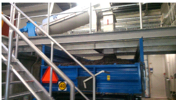
Joonis 6.5 Kohila reoveepuhasti mudatahustusseadmed
