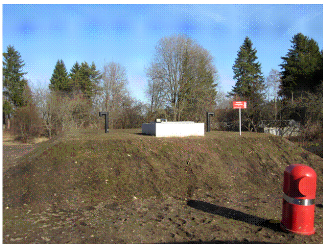
Joonis 5.8 Prillimäe tuletõrjeveemahuti PR-2
