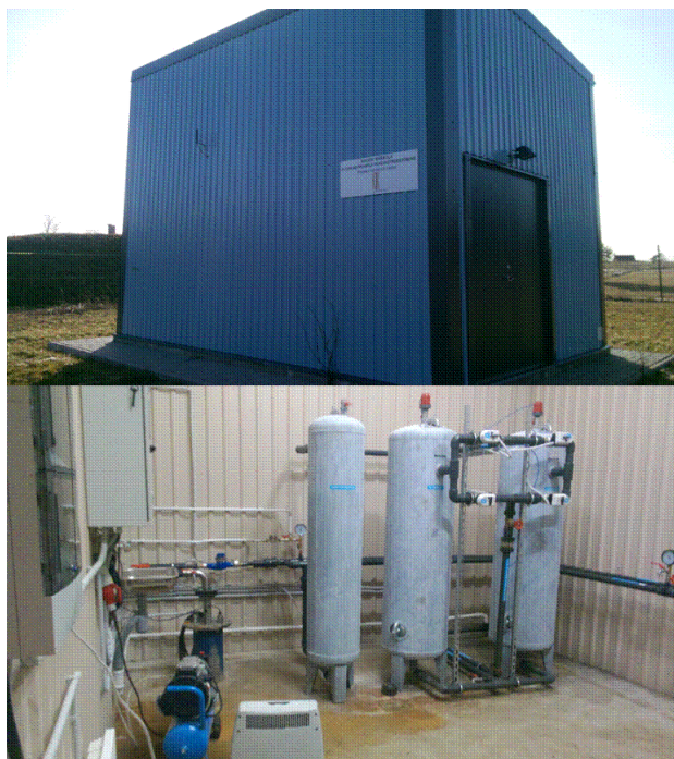
Joonis 5.1 Hageri puurkaevpumppla ja veetöötlusseadmed
