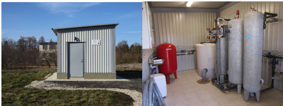
Joonis 5.5 Salutaguse puurkaevpumpla koos veetötlusseadmetega
