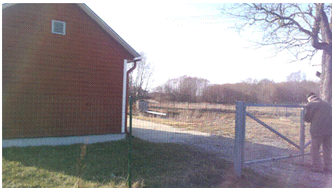
Joonis 6.9 Sutlema reoveepuhasti välisvaade
