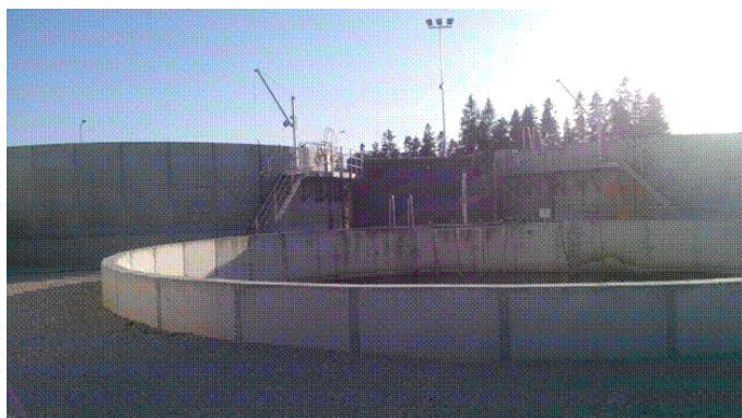
Joonis 6.4 Kohila reoveepuhasti ühtlustusmahuti ja protsessi mahutid
