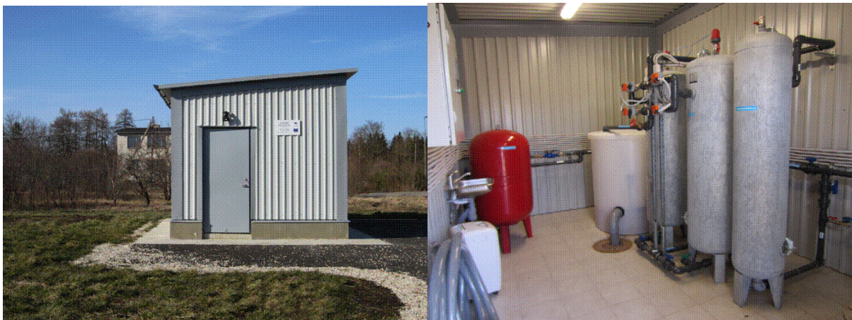
Joonis 5.5 Salutaguse puurkaevpumpla koos veetöötlusseadmetega
