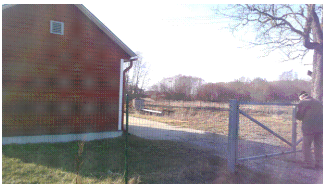
Joonis 6.9 Sutlema reoveepuhasti välisvaade
