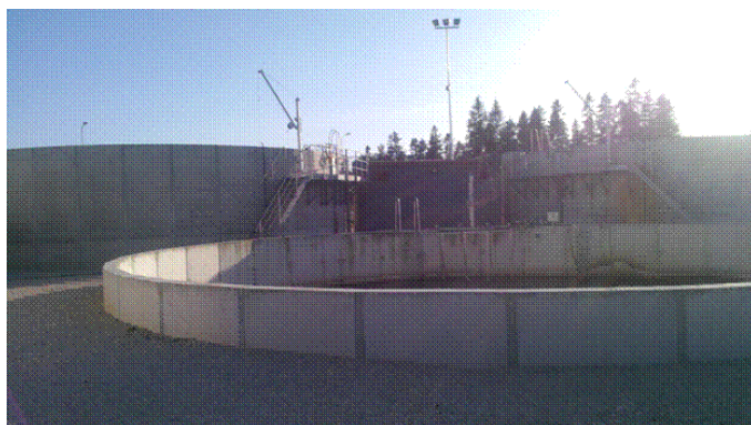
Joonis 6.4 Kohila reoveepuhasti ühtlustusmahuti ja protsessi mahutid
